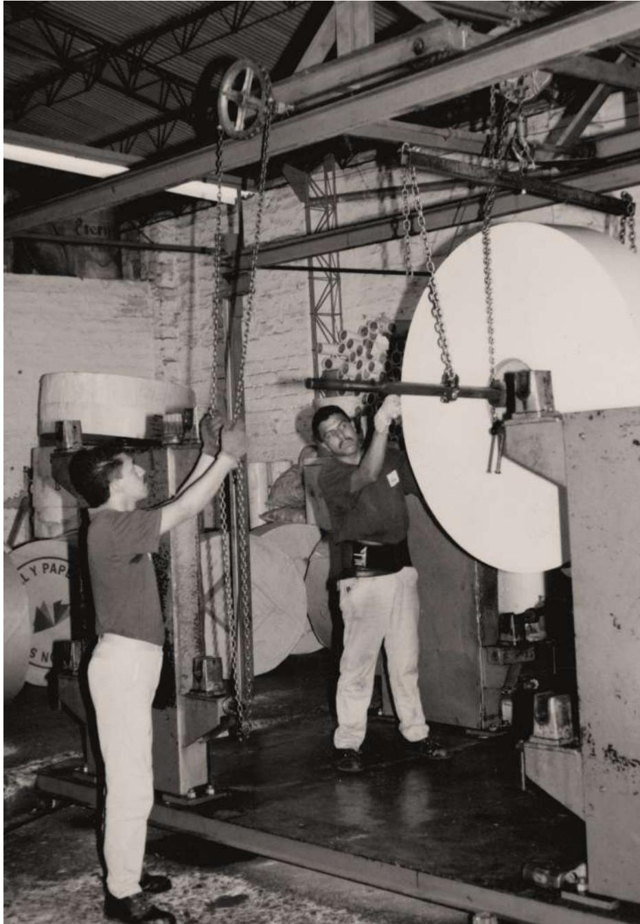
Operarios de la Cooperativa cargando bobina de papel en la máquina convertidora.
